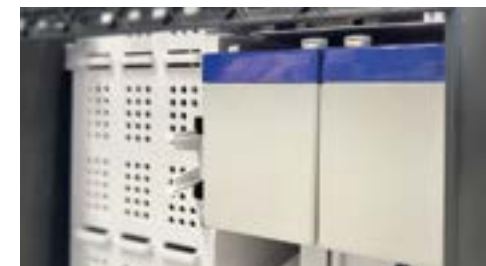
Batterie tampone da 7Ah (opzionali)
