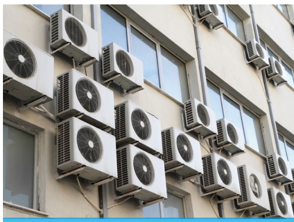
Sistema classico con split esterno Classic system with external split
